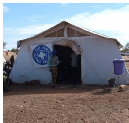
Poste de santé avancé de Sebba
